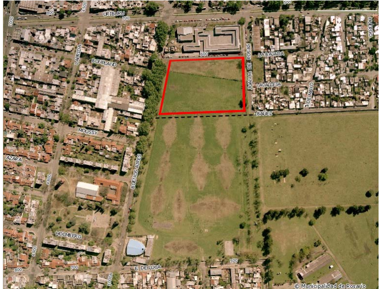
Foto Aérea del Terreno
